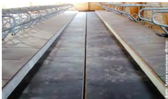
Рисунок 1. Резиновые покрытия для проходов KURA P, резиновые покрытия для стойл ККМ. СПК «Шеметово», Московская область
