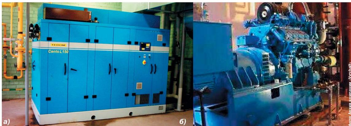
**Рисунок 2.** Когенерационные установки: а – открытого типа, б – закрытого типа.
